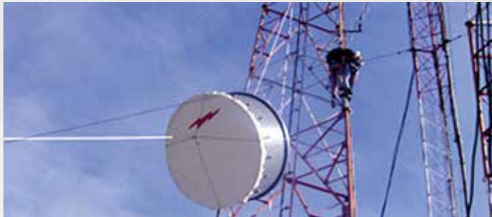
Cliente: TEKONEK para CFE Obra: Instalación de antenas para radioenlaces. Ciudad: Volcán Ceboruco, Jala, Nay.
