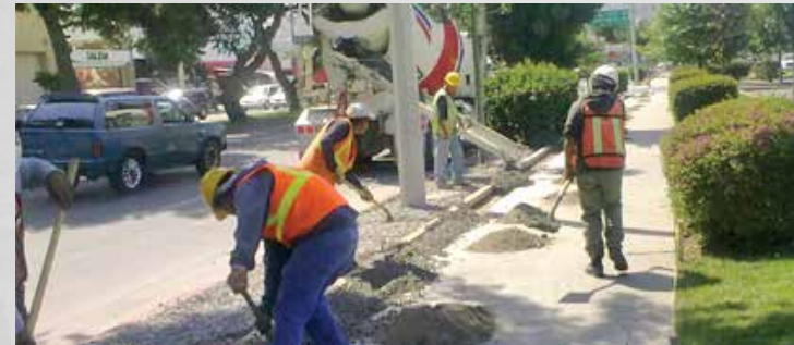
Cliente: Metrored para Transtelco. Obra: Enlace dedicado Ciudad: Tijuana, BC.
