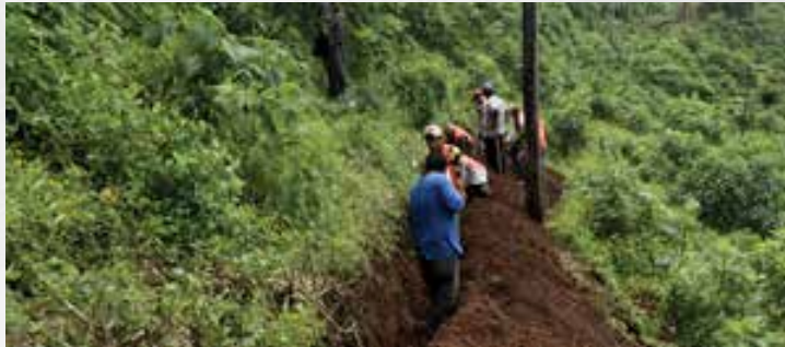
Cliente: CYCOM para GTAC Obra: 1+1 enlace redundante, Tepic II-CFE Ciudad: Tepic, Nay.
