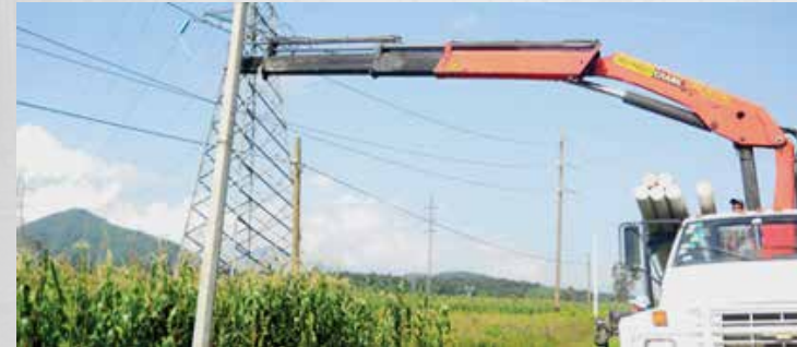
Cliente: CYCOM para GTAC Obra: 1+1 enlace redundante Ciudad: Carapan, Mich.
